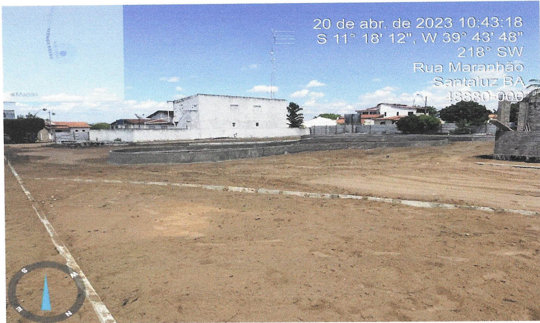
Foto 13 - Meio-fio pré moldado de concreto simples (0,12 x 0,30 x 1,00m), rejuntado com argamassa de cimento e areia no traço 1:3
