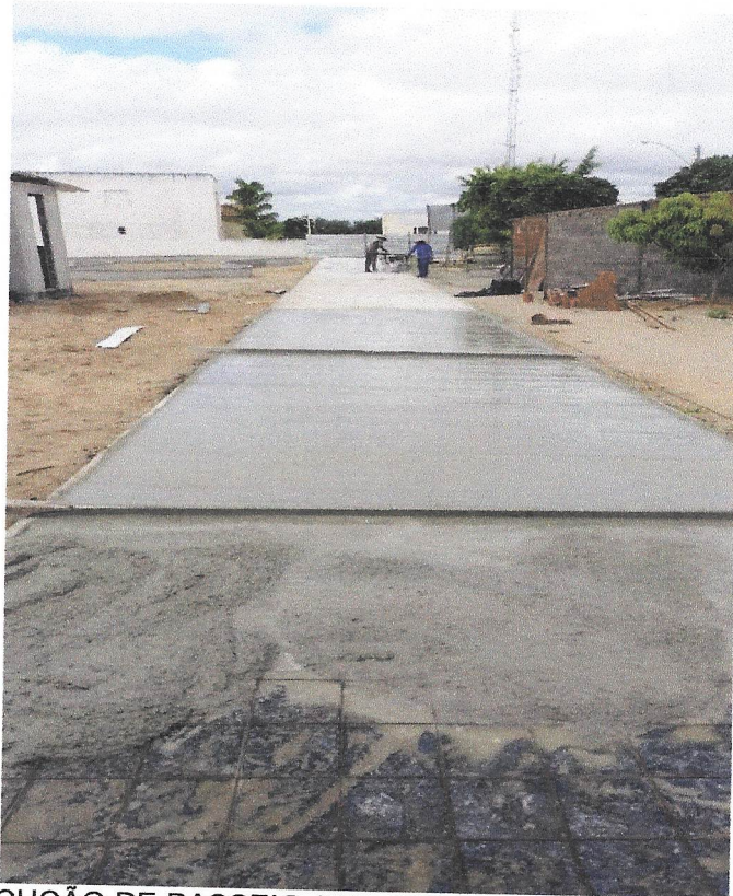
Foto 25 – EXECUÇÃO DE PASSEIO (CALÇADA) OU PISO DE CONCRETO COM CONCRETO MOLDADO IN LOCO, FEITO EM OBRA, ACABAMENTO CONVENCIONAL, ESPESSURA 6 CM, ARMADO. AF_07/2016
