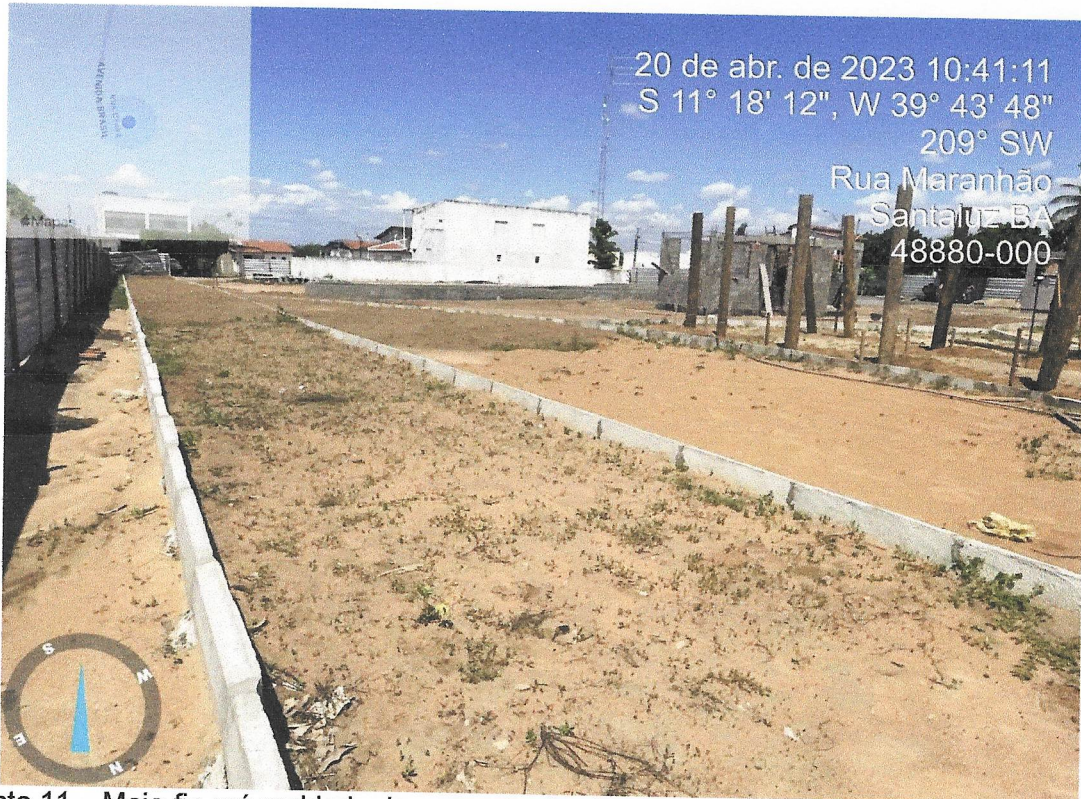
Foto 11 – Meio-fio pré moldado de concreto simples (0,12 x 0,30 x 1,00m), rejuntado com argamassa de cimento e areia no traço 1:3
