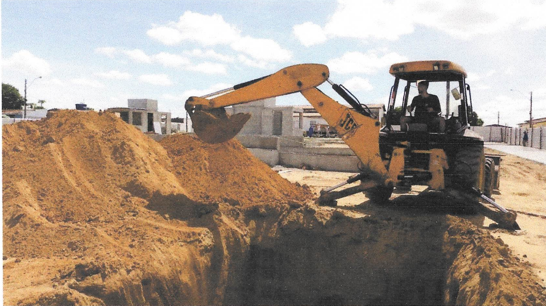
Foto 17 – ESCAVAÇÃO MECANIZADA PARA VIGA BALDRAME COM MINI- ESCAVADEIRA (INCLUINDO ESCAVAÇÃO PARA COLOCAÇÃO DE FÔRMAS). AF_06/2017
