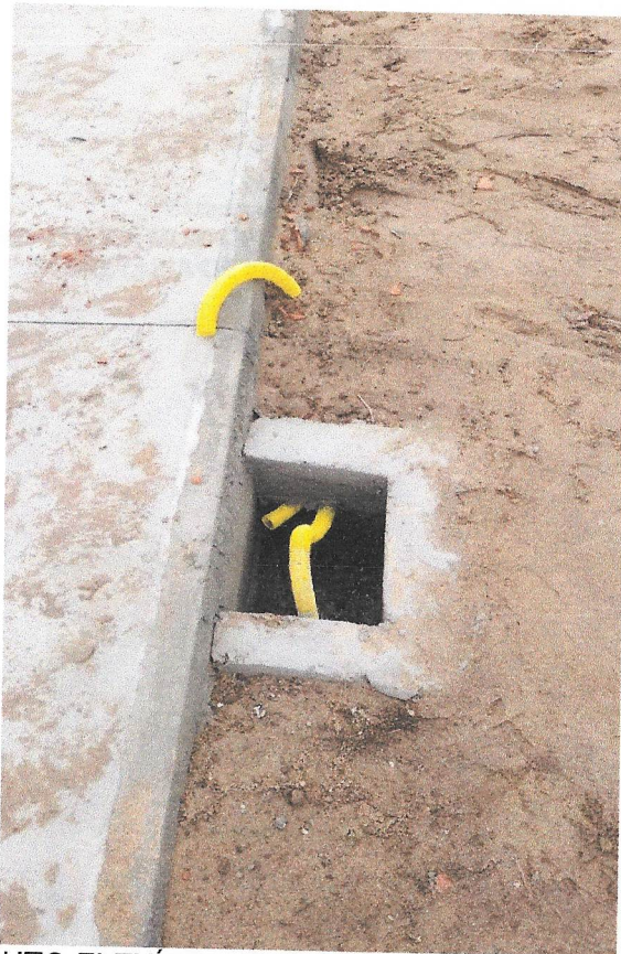
Foto 34 ELETRODUTO FLEXÍVEL CORRUGADO, PVC, DN 25 MM (3/4\"/>
