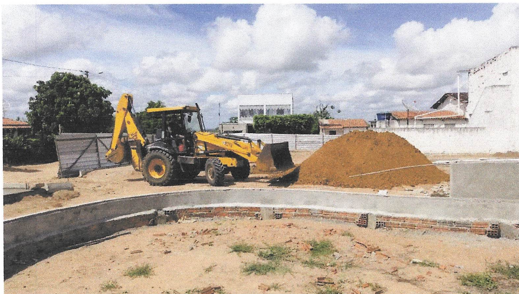
Foto 02 – ATERRO MANUAL DE VALAS COM AREIA PARA ATERRO E COMPACTAÇÃO MECANIZADA. AF_05/2016
