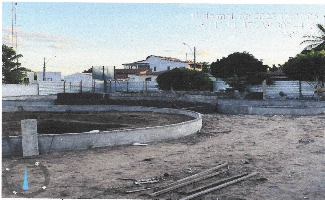
Foto 21 – MASSA ÚNICA, PARA RECEBIMENTO DE PINTURA OU CERÂMICA, ARGAMASSA INDUSTRIALIZADA, PREPARO MECÂNICO, APLICADO COM EQUIPAMENTO DE MISTURA E PROJEÇÃO DE 1,5 M3/H EM FACES INTERNAS DE PAREDES, ESPESSURA DE 5MM, SEM EXECUÇÃO DETALISCAS. AF_06/2014
