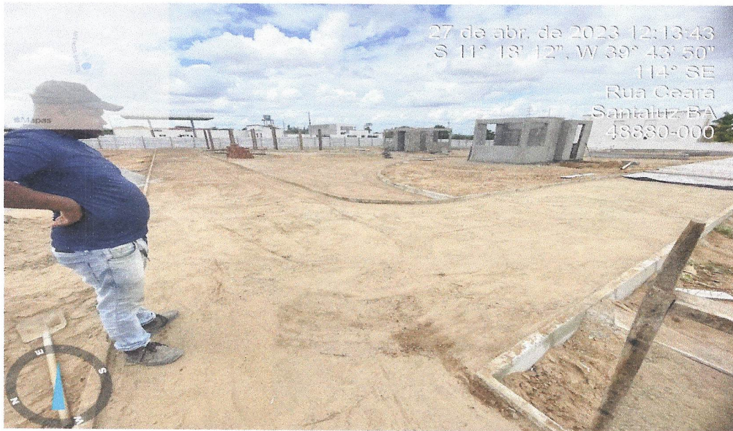
Foto 09 – REGULARIZAÇÃO E COMPACTAÇÃO DE SUBLEITO DE SOLO
