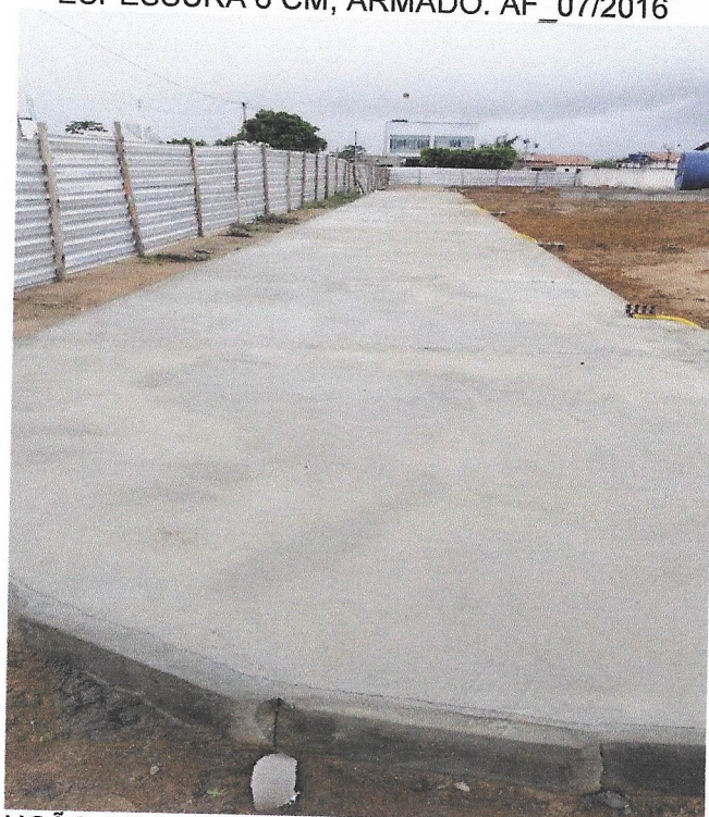
Foto 32– EXECUÇÃO DE PASSEIO (CALÇADA) OU PISO DE CONCRETO COM CONCRETO MOLDADO IN LOCO, FEITO EM OBRA, ACABAMENTO CONVENCIONAL, ESPESSURA 6 CM, ARMADO. AF_07/2016
