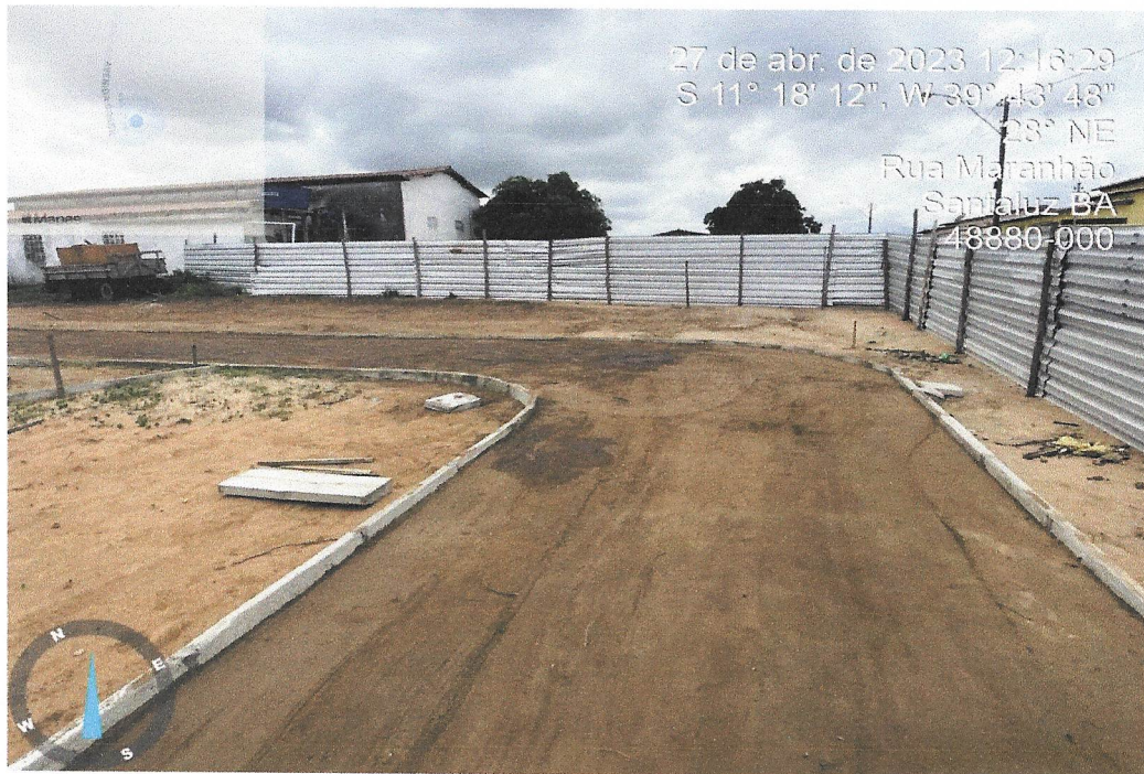
Foto 08 – REGULARIZAÇÃO E COMPACTAÇÃO DE SUBLEITO DE SOLO
