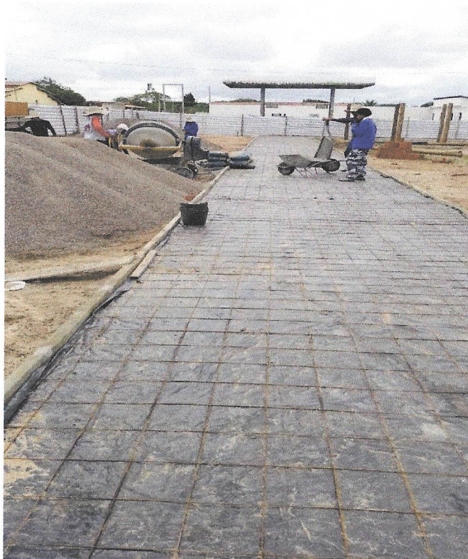
Foto 24 – EXECUÇÃO DE PASSEIO (CALÇADA) OU PISO DE CONCRETO COM CONCRETO MOLDADO IN LOCO, FEITO EM OBRA, ACABAMENTO CONVENCIONAL, ESPESSURA 6 CM, ARMADO. AF_07/2016
