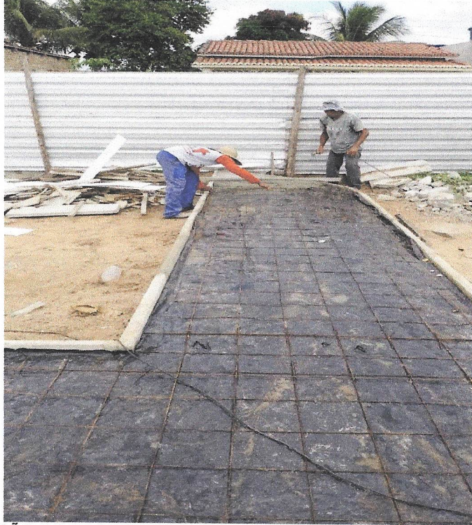
Foto 23 – EXECUÇÃO DE PASSEIO (CALÇADA) OU PISO DE CONCRETO COM CONCRETO MOLDADO IN LOCO, FEITO EM OBRA, ACABAMENTO CONVENCIONAL, ESPESSURA 6 CM, ARMADO. AF_07/2016
