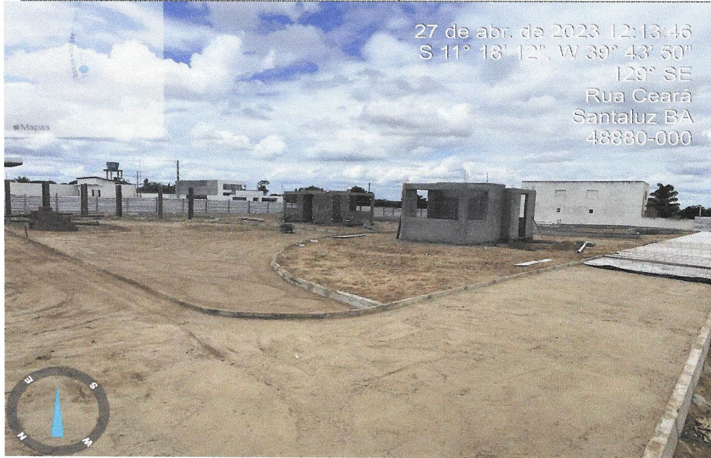
Foto 07 – REGULARIZAÇÃO E COMPACTAÇÃO DE SUBLEITO DE SOLO
