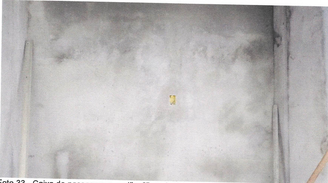
Foto 33 - Caixa de passagem pvc, 4" x 2", embutir, p/eletroduto - Rev 01 E ELETRODUTO FLEXÍVEL CORRUGADO, PVC, DN 25 MM (3/4).
