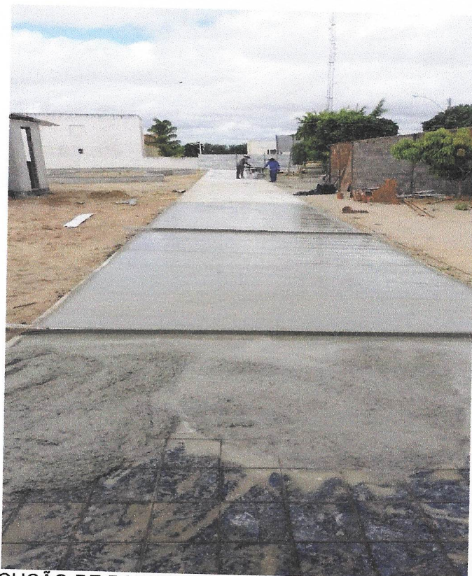
Foto 31 – EXECUÇÃO DE PASSEIO (CALÇADA) OU PISO DE CONCRETO COM CONCRETO MOLDADO IN LOCO, FEITO EM OBRA, ACABAMENTO CONVENCIONAL, ESPESSURA 6 CM, ARMADO. AF_07/2016
