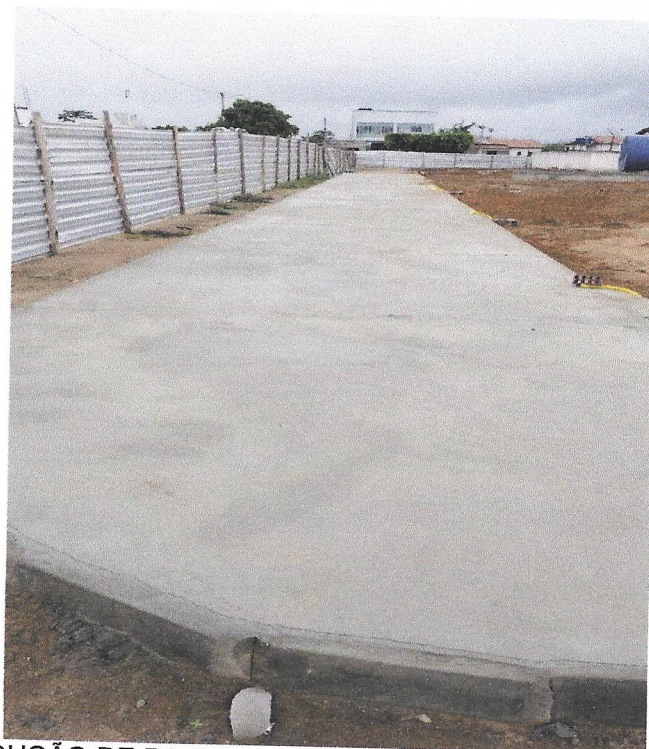
Foto 26 – EXECUÇÃO DE PASSEIO (CALÇADA) OU PISO DE CONCRETO COM CONCRETO MOLDADO IN LOCO, FEITO EM OBRA, ACABAMENTO CONVENCIONAL,
