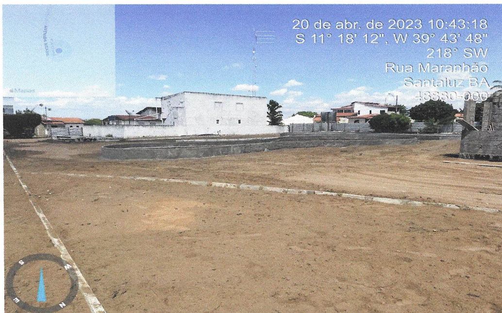
Foto 06 – ATERRO MANUAL DE VALAS COM AREIA PARA ATERRO E COMPACTAÇÃO MECANIZADA. AF_05/2016
