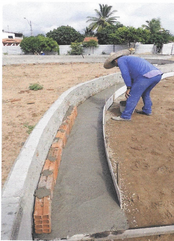
Foto 22 - MASSA ÚNICA, PARA RECEBIMENTO DE PINTURA OU CERÂMICA, ARGAMASSA INDUSTRIALIZADA, PREPARO MECÂNICO, APLICADO COM EQUIPAMENTO DE MISTURA E PROJEÇÃO DE 1,5 M3/H EM FACES INTERNAS DE PAREDES, ESPESSURA DE 5MM, SEM EXECUÇÃO DE TALISCAS. AF_06/2014
