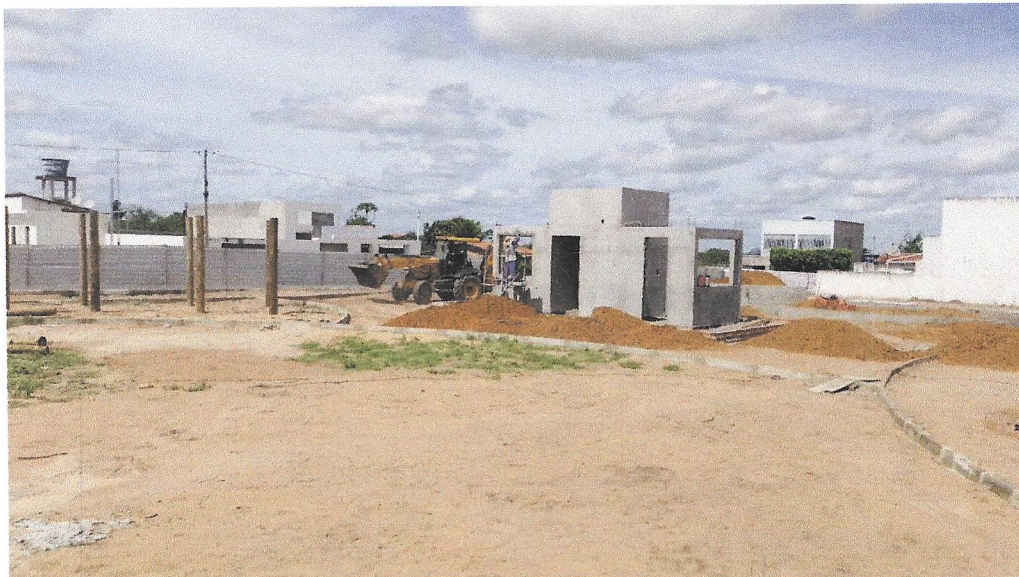
Foto 01 – ATERRO MANUAL DE VALAS COM AREIA PARA ATERRO E COMPACTAÇÃO MECANIZADA. AF_05/2016
